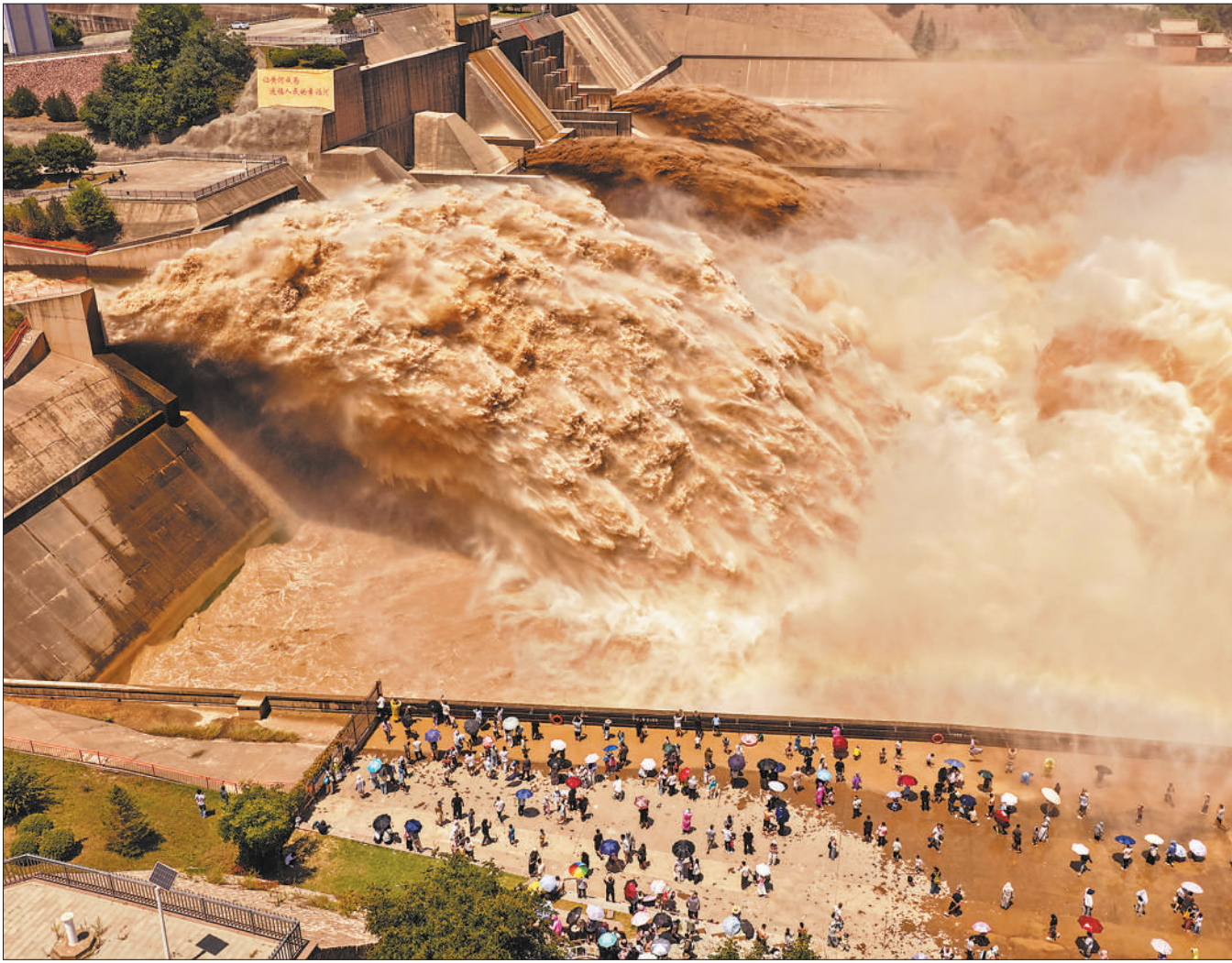
自6月22日黄河2026年主汛期前调水调沙启动以来，经过10余天大流量下泄，小浪底水利枢纽进入排沙阶段，水库排沙量预计将超1亿吨。排沙期间，小浪底水利枢纽将密切关注高含沙水流演进态势，利用数字孪生小浪底进行滚动预演，科学制定孔洞组合方案，更好促进排沙出库，实现水库减淤。 图为7月5日，小浪底水利枢纽大流量高含沙排沙现场。
