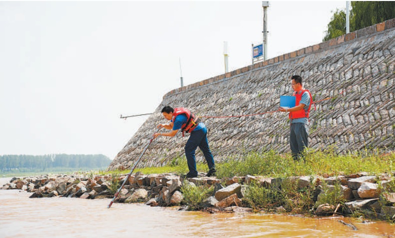
山东邹平市台子镇,防汛工作人员在黄河岸边进行根石探测和巡逻,保障汛期河道安全。
