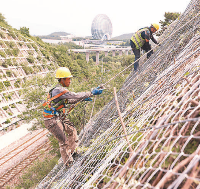
北京怀柔区雁栖湖畔,施工人员为京通铁路安装边坡护网,防止山体滑坡和落石侵入线路,确保汛期铁路运输安全。
