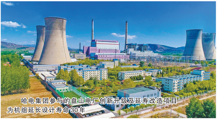
哈电集团参与的盘山电厂创新升级及延寿改造项目为机组延长设计寿命30年
