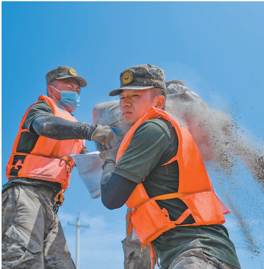
▲2025年8月，内蒙古呼和浩特市土默特左旗善岱镇独土坝村发生泄洪堤垮塌后，善岱镇党委充分发挥统筹协调作用，各方力量齐心协力，守护群众生命财产安全。图为武警官兵正开展封堵作业。 张 彬 杨 鑫摄影报道
