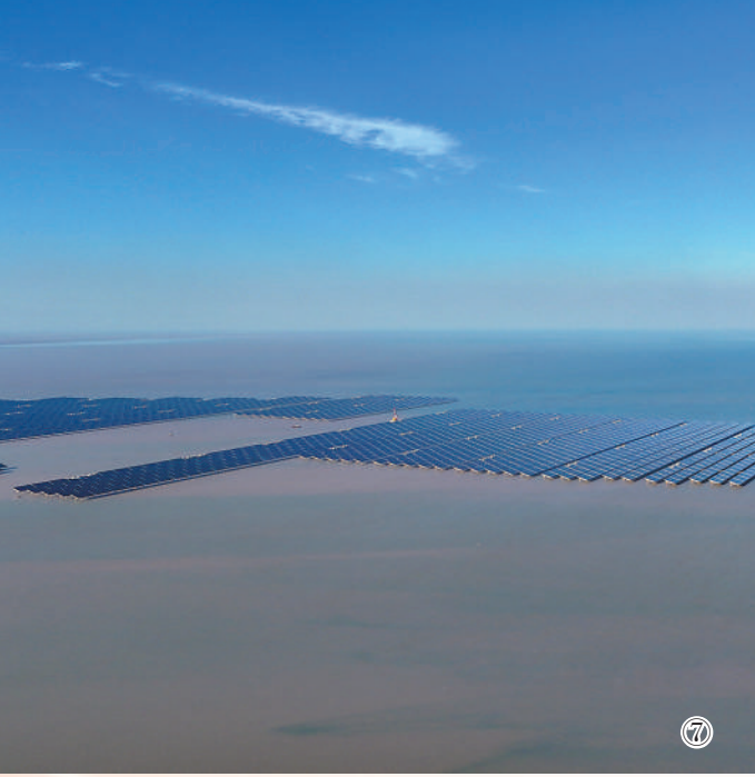
图⑦:山东省东营市吉瓦级桩基固定式海上光伏项目——国华HG14海上光伏项目(无人机照片)。 周广学摄(新华社发)
