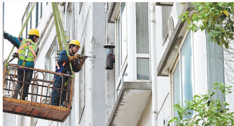
▲江苏省太仓市浏河镇,工人在老旧小区进行加装电梯施工。
