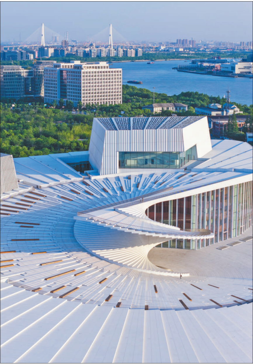
6月23日,有“中国扇”之称的上海大歌剧院宣布竣工。上海大歌剧院坐落于浦东新区世博文化公园内,总面积达14.6万平方米,从空中俯瞰形似白色巨扇。歌剧院内部由2000座的红厅、1200座的申厅、1000座的镜厅和艺术教育空间乐厅组成,覆盖从经典驻场到前沿实验、从专业演出到艺术普及的完整演艺生态。
