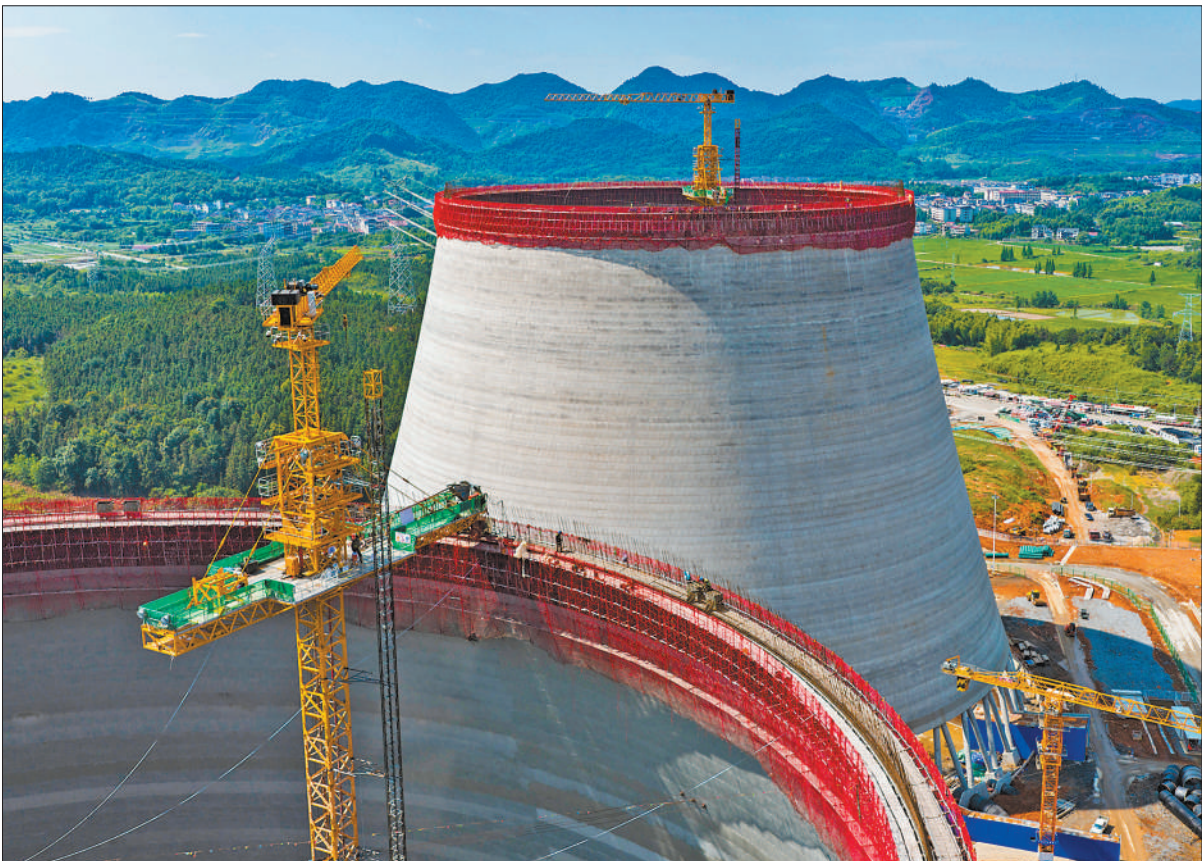
6月22日,江西省新余市分宜发电厂2×1000兆瓦机组扩建工程加速推进。该项目建成后,将缓解地区电力供需矛盾,提升区域电网支撑能力。图为工程建设现场。赵春亮摄(影像中国)
