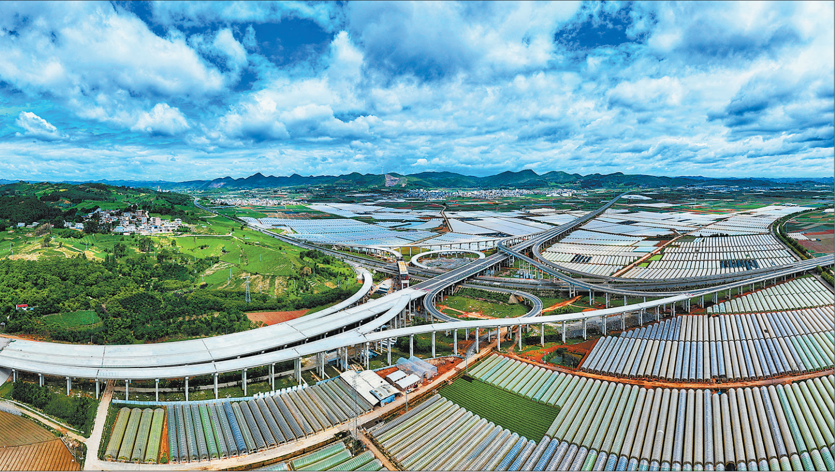
云南省红河哈尼族彝族自治州泸西县至文山壮族苗族自治州丘北县高速公路逸园枢纽互通主体工程目前进入桥面系施工及附属收尾阶段。泸丘高速公路全线总长27.518公里，桥隧比达72%。逸园枢纽互通工程地处泸西县中枢镇夸西村，可串联周边三条高速公路，是区域关键交通转换节点。图为6月22日拍摄的逸园枢纽互通工程建设现场。
