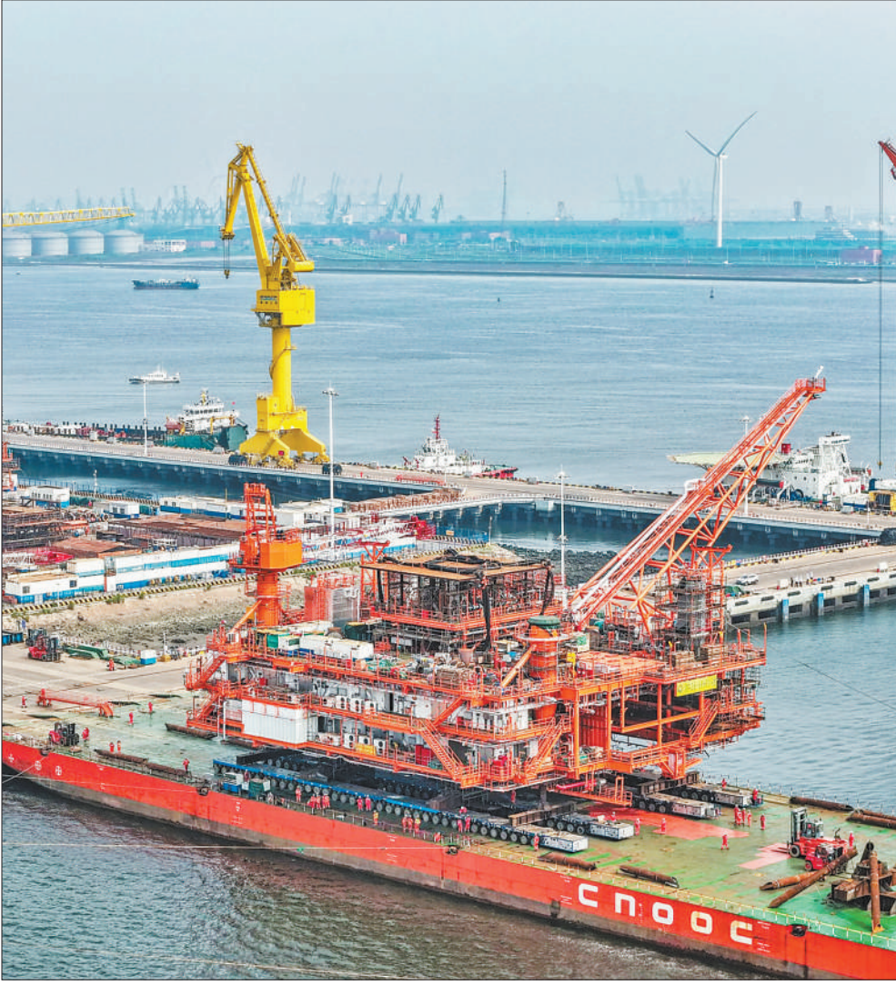
6月16日，随着最后一座平台在天津市滨海新区成功装船，全球最大变质岩油田渤中26—6油田开发项目（二期）全部平台陆地建造完工，为油田按期投产奠定基础。 图为渤中26—6油田开发项目（二期）平台完工装船现场。
