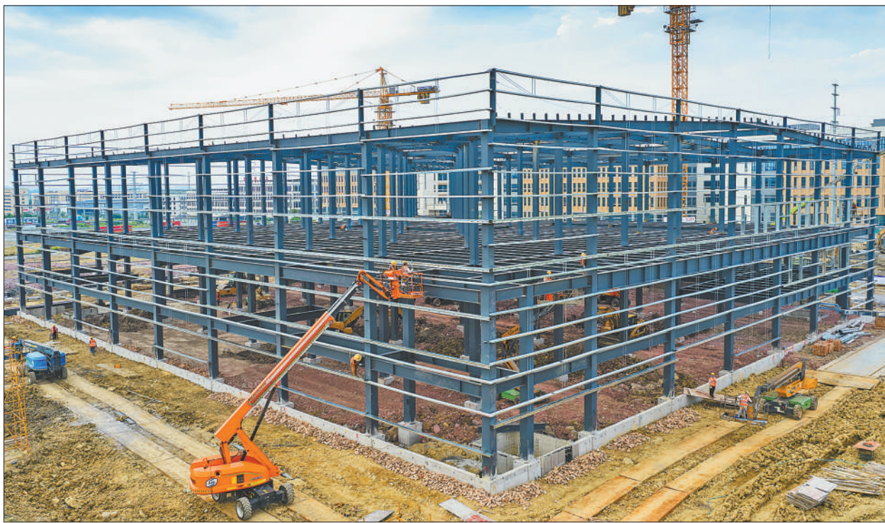
6月2日,湖南省永州市冷水滩区高科园冷链物流项目正在建设。该项目总建筑面积约3.7万平方米,建成后 will 有效减少粮食、蔬菜等产后损失和流通环节浪费。雷中祥摄(影像中国)
