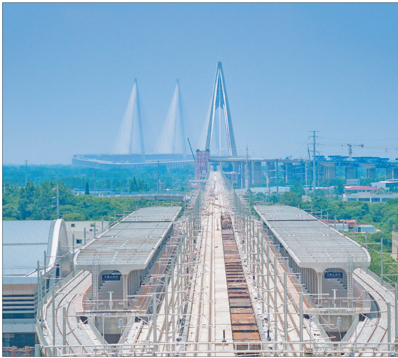
5月27日，新建巢湖至马鞍山高速铁路正式启动静态验收工作，标志着该高铁主体工程建设基本完成。
