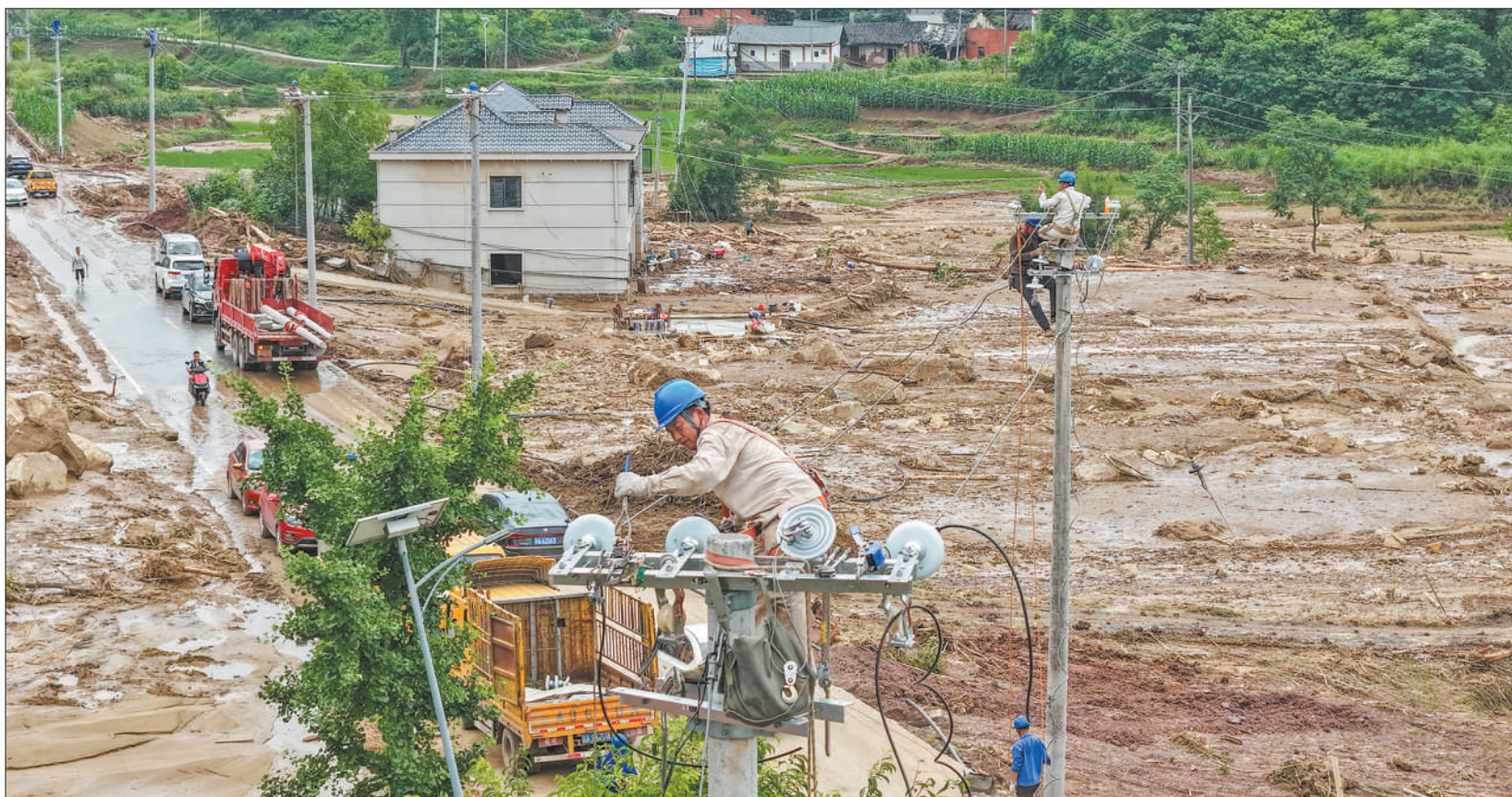
5月26日, 在重庆市永川区茶山竹海街道安溪村, 工作人员在抢修供电线路。5月23日夜后至24日凌晨, 永川区突发短时强降雨引发山洪和地质灾害, 当地全力开展抢险救援。新华社记者 黄伟摄
