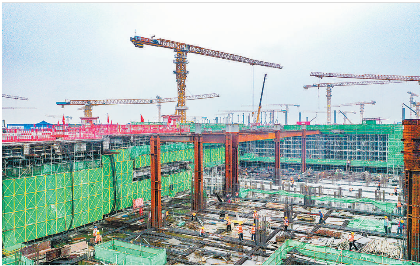
5月19日，位于江苏省南京市江北新区的南京北站轨交主体结构全部完工。南京北站是江苏省铁路交通体系的重要枢纽，也是南京唯一集高速铁路、城际铁路、普通铁路于一体的综合客站。作为国家级综合交通重点工程，南京北站启用后，将补齐南京“米”字形高铁网关键拼图，助力提升南京都市圈中心城市辐射能力。
