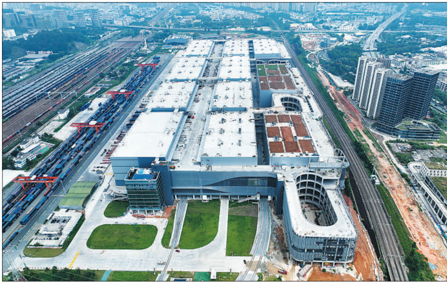
深圳平湖南综合物流枢纽项目全景。
