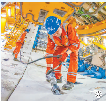
图①:海太长江隧道工程施工现场航拍。图②:海太长江隧道成型隧道内景。图③:施工人员紧固管片螺栓。以上图片均为范少文摄
