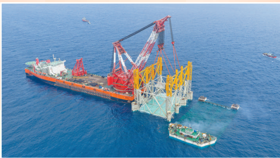
五粮液生态园区。广东阳江海城,阳江三山岛海上风电梁直输电工程海上换流站导管架精准落座预定海床,顺利完成安装。南方电网公司供图
