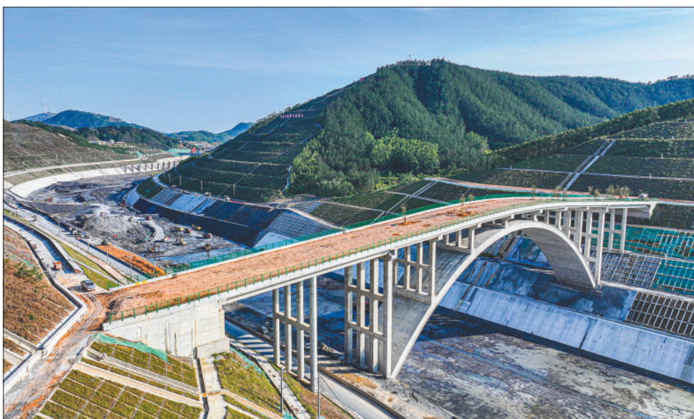
图为建设中的平陆运河野生动物专属通道桥。
