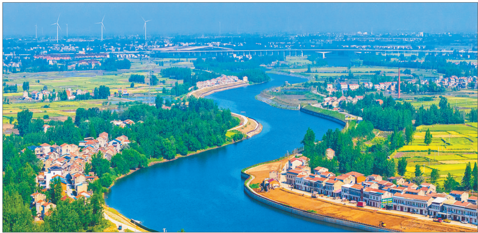
老府河是湖北孝感市境内的重要河流，当地通过岸坡整治、河面拓宽、水闸重建以及生态修复、水环境改善等工程，不仅提升了防洪、调蓄、灌溉能力，更为区域绿色可持续发展奠定基础。图为近日拍摄的老府河，水清、河畅、岸绿、景美。胡学军摄（人民视觉）
