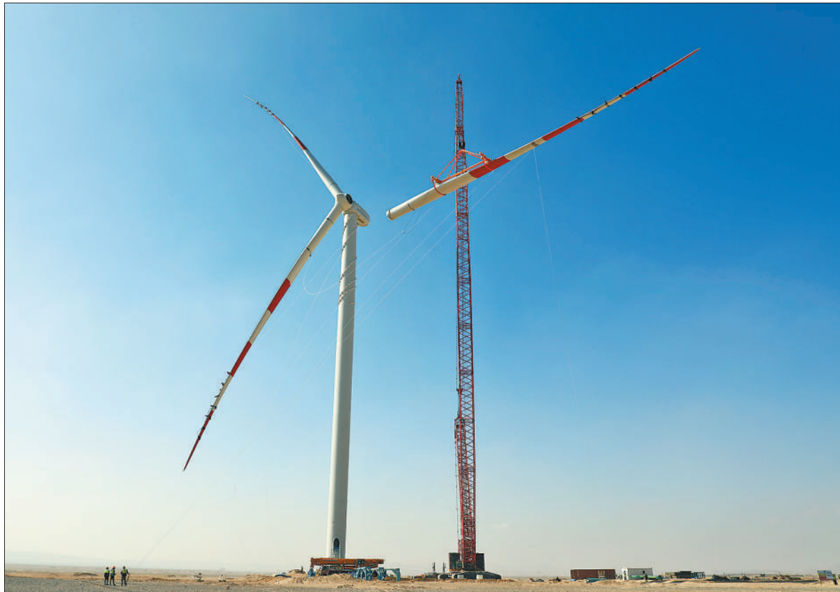
苏伊士湾1.1吉瓦风电项目现场，工作人员正在进行风机吊装作业。
