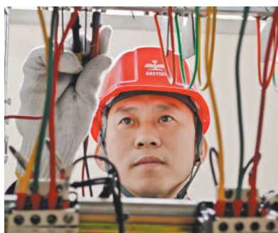
马志刚在检修电气设备。受访者供图
