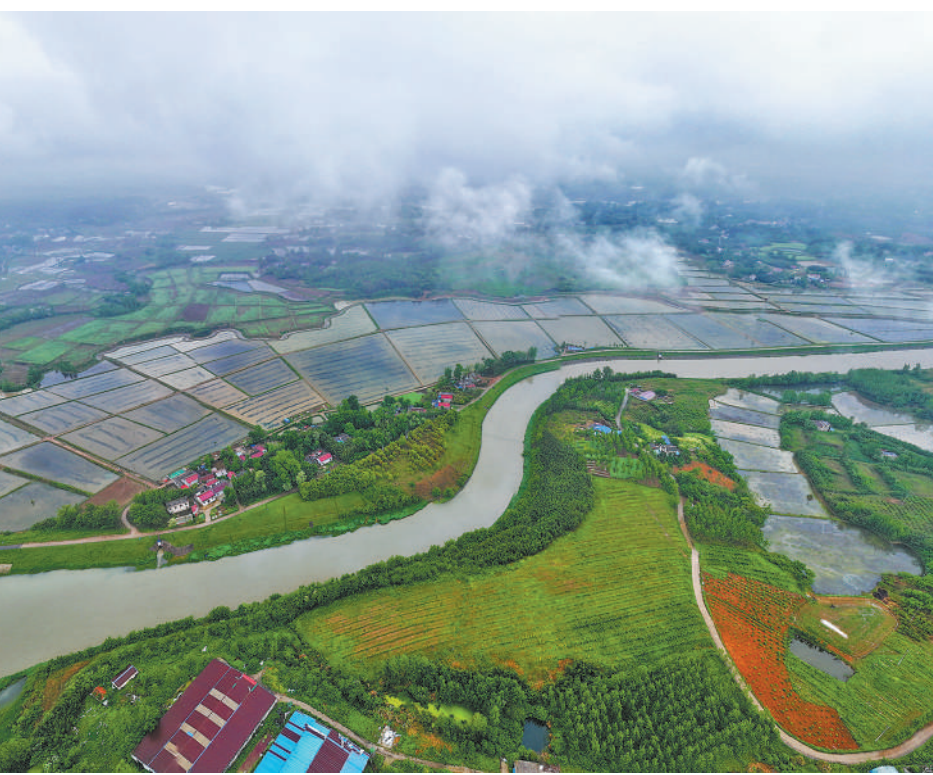
图为4月24日，淠史杭灌区史河总干渠为春耕送水。
