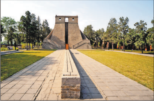
▲位于郑州登封市的观星台，是“天地之中”历史建筑群的组成部分。 马 健摄
