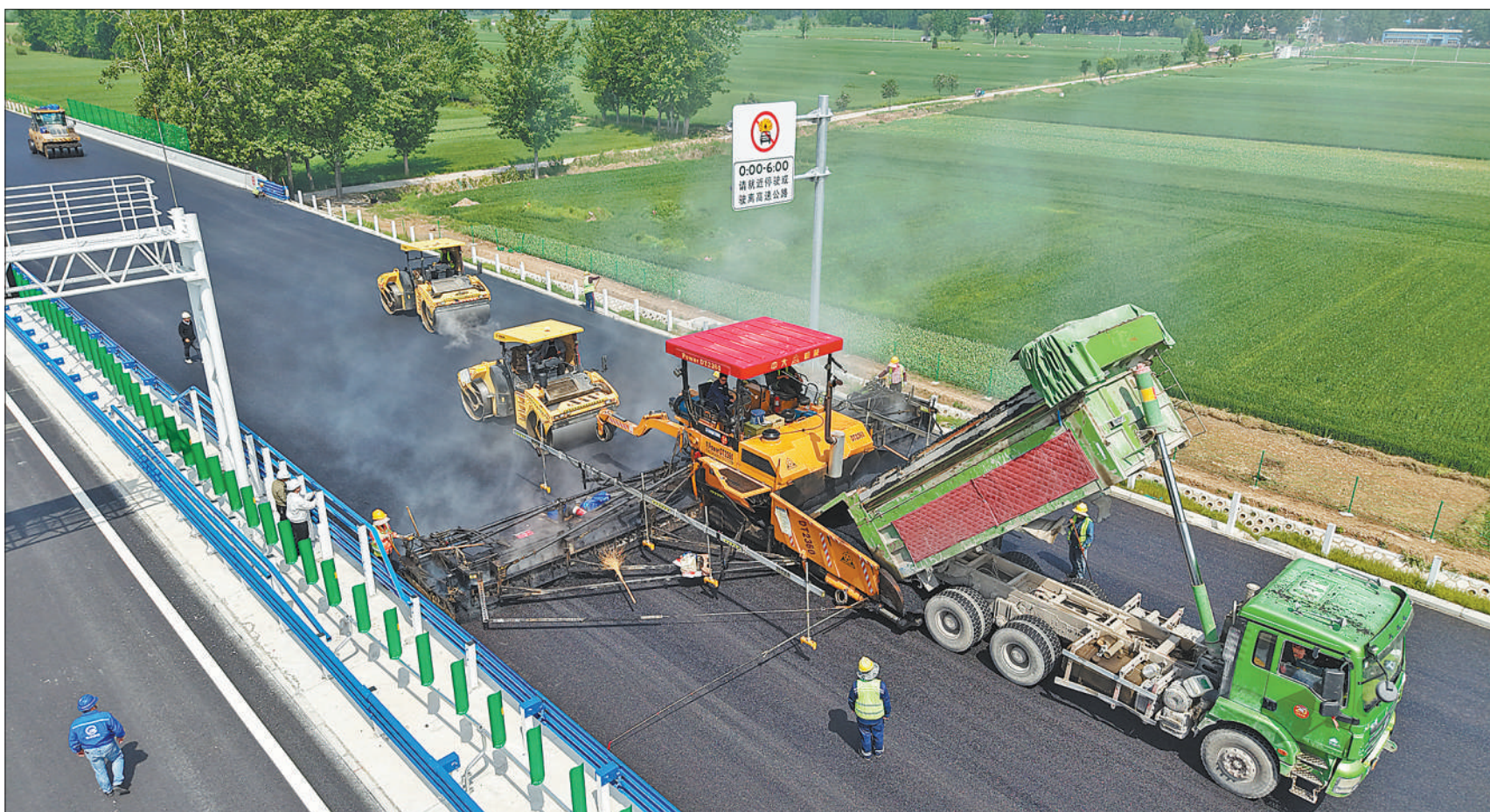
4月23日，沿黄高速公路河南兰考至封丘段项目全线沥青面层施工完成，标志着该工程跨黄河通道主体工程全面完成。图为工作人员在该项目兰考路段进行沥青摊铺。
