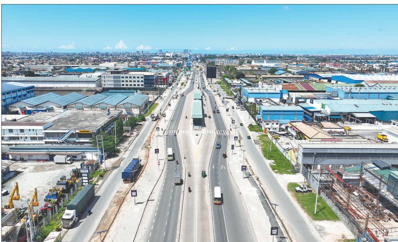
由中国电建承建的坦桑尼亚达累斯萨拉姆快速公交三期项目一标段日前完工。该项目连接尼雷尔国际机场与达累斯萨拉姆市区,是坦桑尼亚优化城市交通结构、提升居民出行效率的重点民生工程。项目建设高峰期当地提供超1200个就业岗位,带动当地经济发展。
