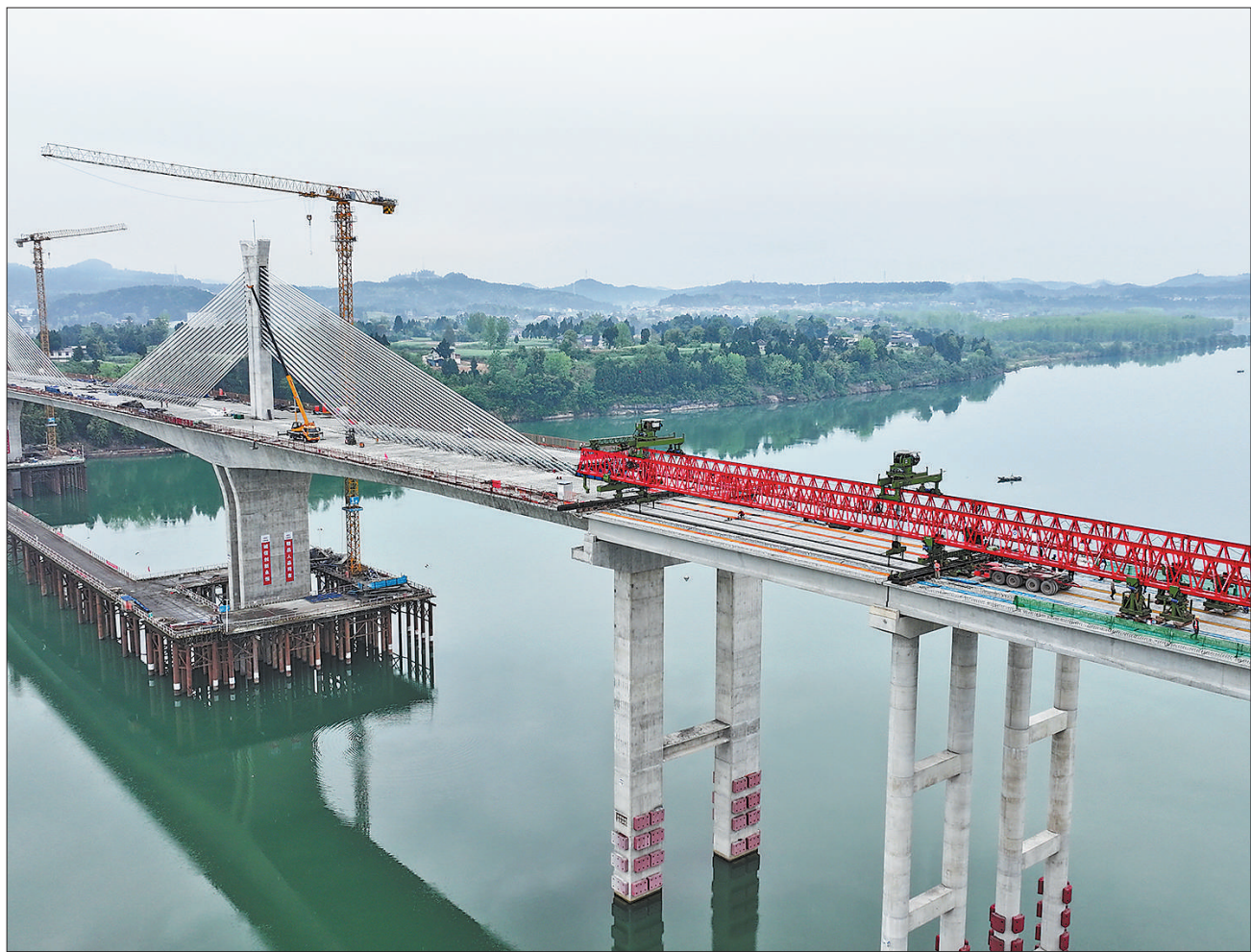
4月13日，四川省阆中市至营山县高速公路控制性工程——嘉陵江特大桥左幅顺利贯通，标志着大桥建设取得阶段性突破，为阆营高速年底通车奠定坚实基础。阆营高速全长约103公里，建成通车后，阆中市至营山县通行时间将从2.5小时缩短至40分钟。图为大桥左幅架设最后一跨40米T型梁。 王玉贵摄(影像中国)
