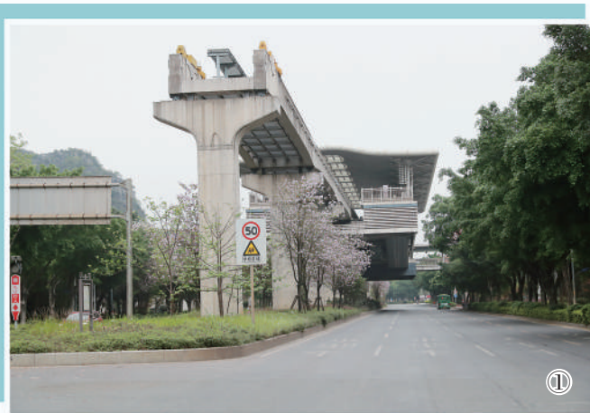
图①：柳州市轻轨墩柱。
