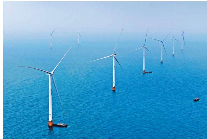
图为龙源电力海南启源海风场。
