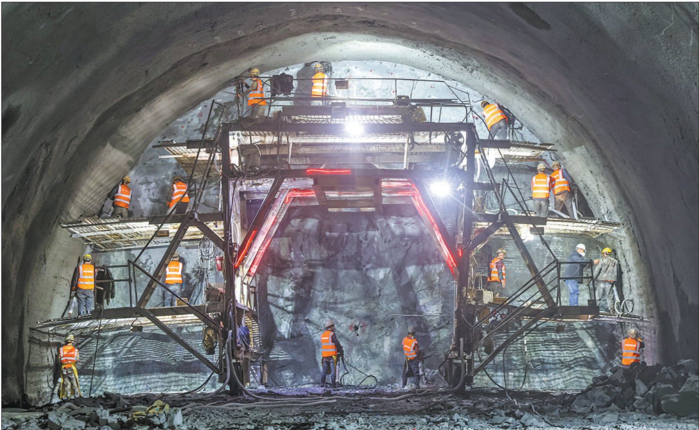
1 月 22 日，甬舟铁路项目舟山本岛段双石岩隧道进口段掘进施工现场，工人们正操纵风钻在掌子面进行打孔作业，同时隧道二衬也在同步跟进。目前，两端掘进合计已经过半。姚峰摄（影像中国）
