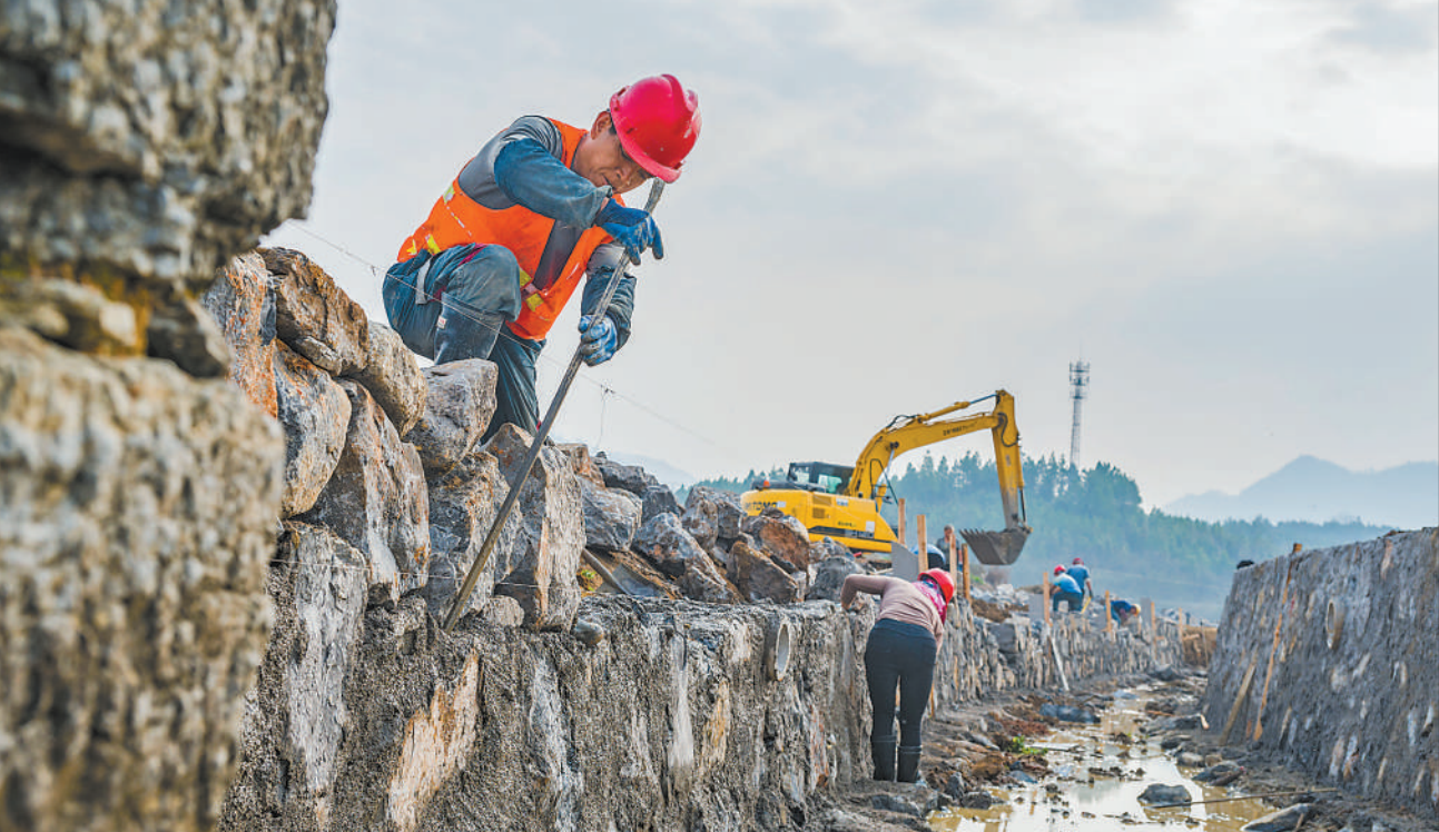
1月15日,湖南娄底市双峰县双辉村高标准农田建设项目区,工人正在进行河堤石砌护坡作业。入冬以来,双峰县全面推进高标准农田建设,通过田块整治、水利配套、道路优化等系统工程,改善农业基础设施条件,提升耕地质量。 李建新摄(人民视觉)
