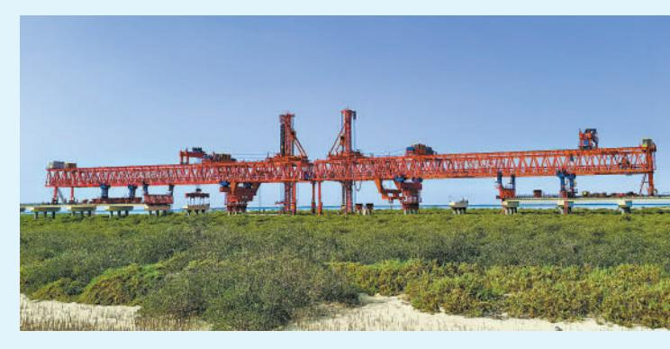
近日,由中国港湾承建、中交四航局负责实施的沙特红海拉赫连接路与跨海桥项目开展合龙施工,两台桩梁一体智能造桥机在红海“相会”。为保护当地红树林浅水区生态,中企研发了集引孔、打桩、架梁于一体的智能施工平台,实现全过程空中作业,为红树林留出完整的生长空间。
