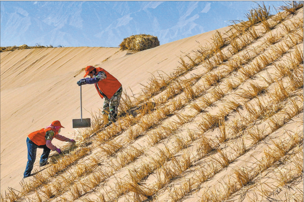
11月13日，在甘肃省张掖市肃南裕固族自治县明花乡，治沙工人营建沙障和固沙林带，为沙漠“锁边”。明花乡位于巴丹吉林沙漠边缘，是国家“三北”防护林体系建设和北方防沙带的关键区域。近年来，当地统筹推进山水林田湖草沙一体化治理，实施固沙造林，有效遏制了沙漠扩张。
