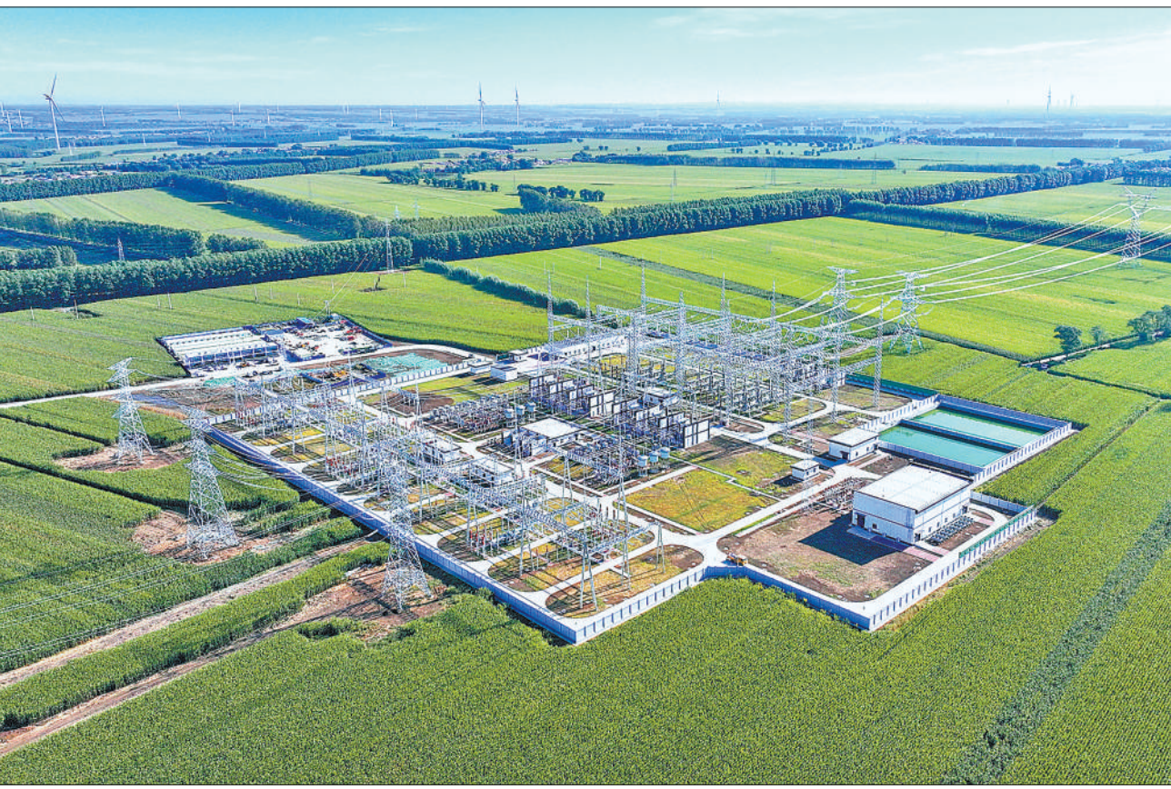
9月20日，辽宁铁岭500千伏西泉变电站成功送电。这一工程自2024年3月开工建设，可满足超过200万千瓦风电、太阳能发电等新能源并网需求，每年可新增清洁能源消纳超30亿千瓦时。
