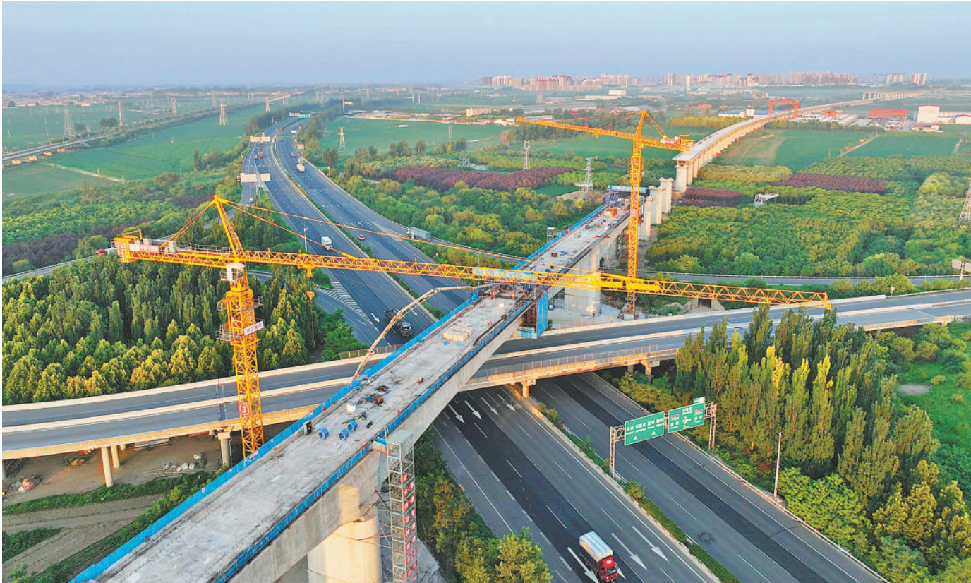
雄忻高铁保定东特大桥跨京港澳高速连续梁中跨7月18日合龙。雄忻高铁起自雄安新区，终到忻州西站，正线全长342公里，是我国“八纵八横”高速铁路网京昆通道的重要组成部分，也是雄安新区“四纵两横”区域高铁网的重要横向通道。图为雄忻高铁保定东特大桥跨京港澳高速连续梁中跨施工现场。
