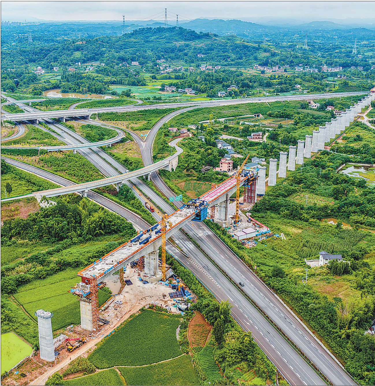
7月8日,由中铁五局承建的成渝中线高铁土桥枢纽互通双线特大桥连续梁顺利合龙,该连续梁全长约242米,是成渝中线高铁重庆段跨度最大的连续梁。土桥枢纽互通双线特大桥位于重庆市铜梁区,全长3271.6米,上跨重庆三环高速及铜安高速公路。成渝中线高铁是我国“八纵八横”高铁网沿江通道的重要组成部分,正线全长292公里,设计时速350公里。
