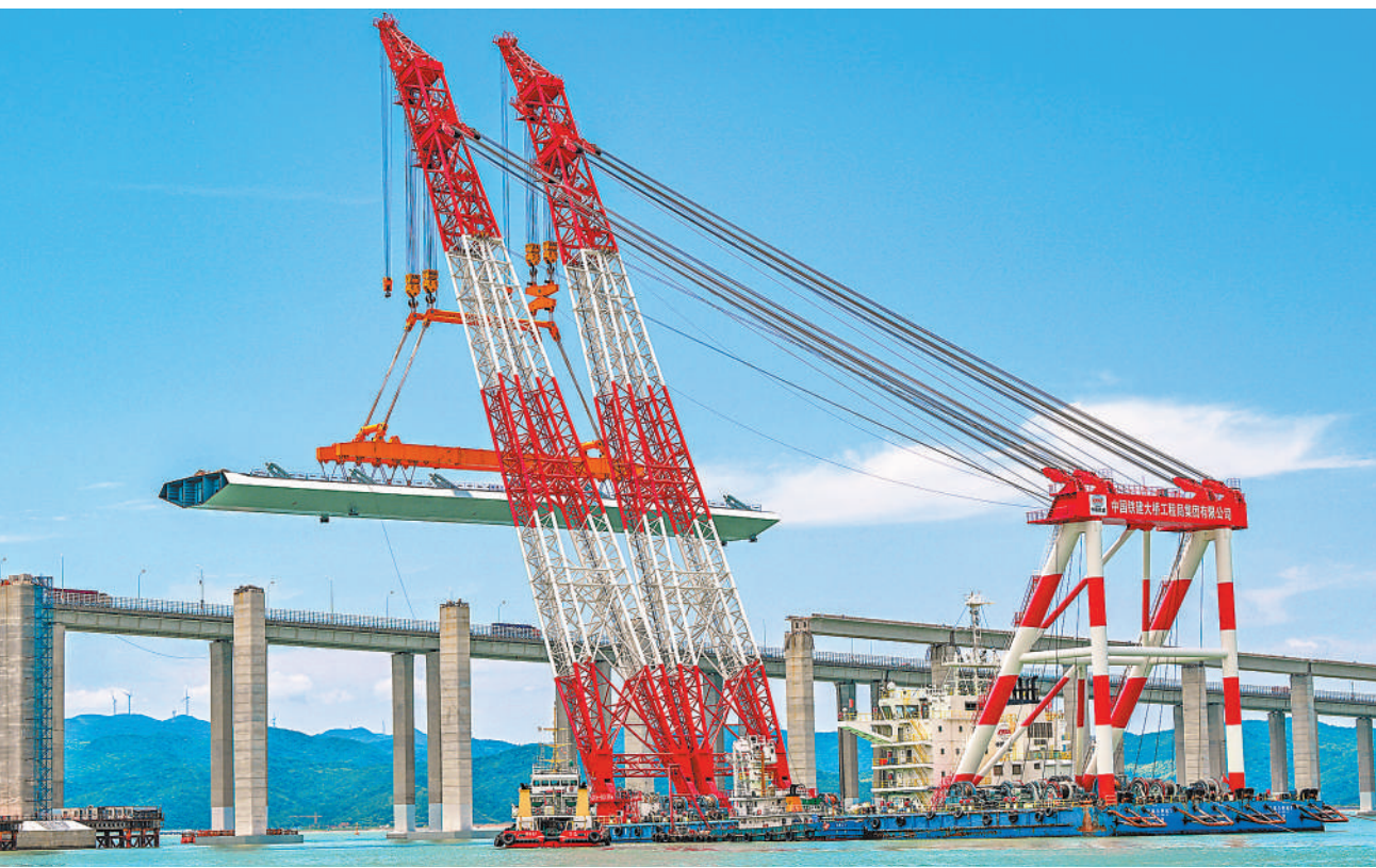
浙江宁波市象山跨海大桥最大重量节段钢混结合梁6月16日架设成功,为后续主梁架设、斜拉索施工奠定坚实基础。全桥主梁共分为95节钢箱梁,此次架设的边跨大节段钢混结合段由7个独立梁段拼接而成,梁长107.5米,重1619吨。 胡学军摄(影像中国)
