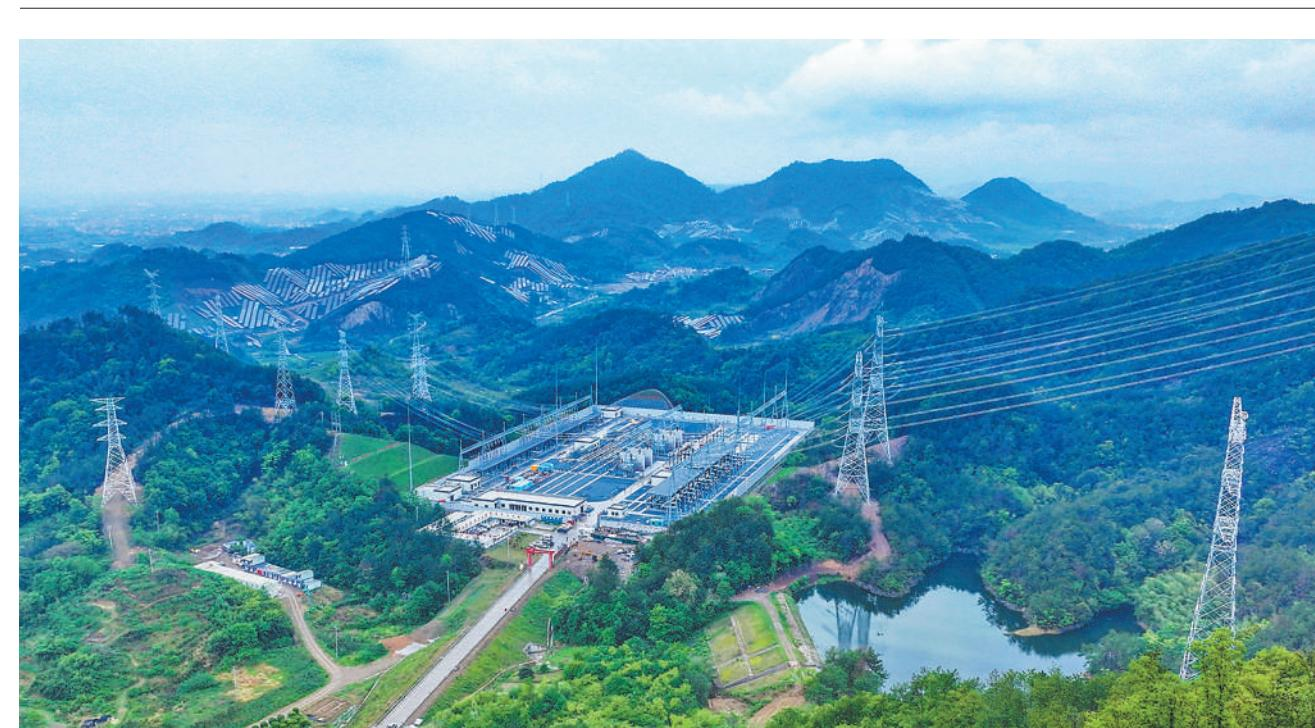
全模块化超高压变电站——500千伏潘村变电站5月22日在浙江金华投运。该变电站投运200万千瓦安主变容量及11回输电线路，通过“双开口”特高压接入设计，每年可输送7.28亿千瓦时光伏绿电，为地方经济高质量发展注入绿色动能。
