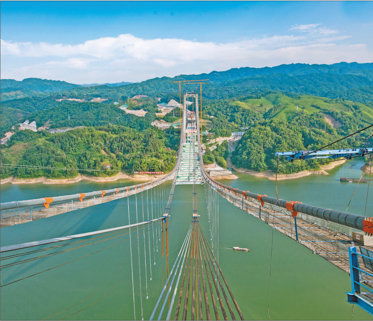
5月13日，湖南怀化沅陵县，张(家界)官(庄)高速公路关键控制性工程洞庭溪沅水特大桥正在进行钢混组合梁吊架施工。该桥主桥设计为跨径800米的双塔单跨悬索桥，是湖南在建跨径最大的悬索桥。
