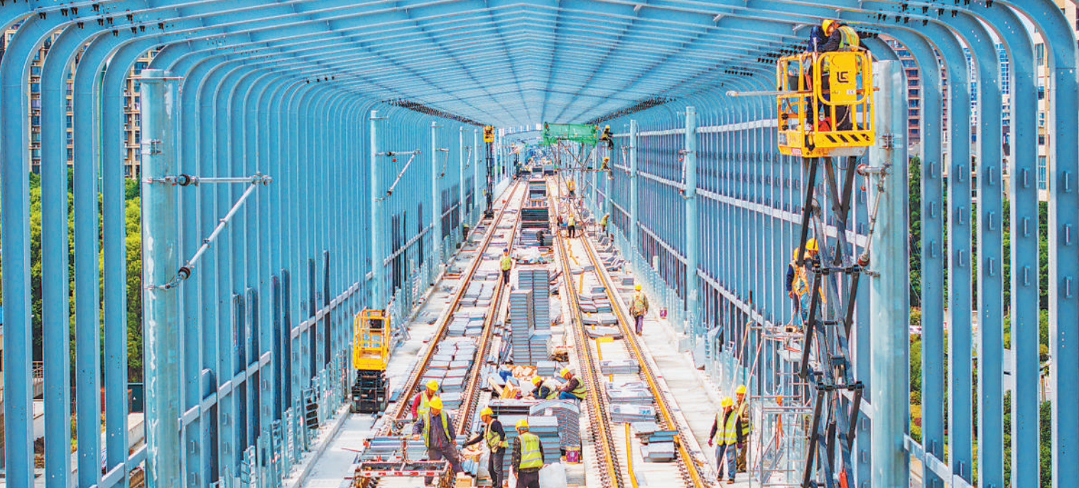
宁马城际铁路是连接江苏南京与安徽马鞍山的一条城际通勤铁路，通车后将实现两市中心城区30分钟通达，给两地居民往来带来便利，助力长三角一体化高质量发展。 图为5月10日，马鞍山花山区的宁马城际铁路建设现场，工人在安装声屏障。 张明伟摄（影像中国）
