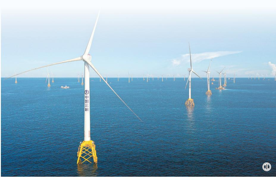
“和一般的固定式风机不同，这种漂浮式风机是由锚链系于海底。”滕华灯解释，“它是个巨型‘不倒翁’，使用了不少创新技术，能抵御超17级台风，是海上风电迈向深远海的利器。”
