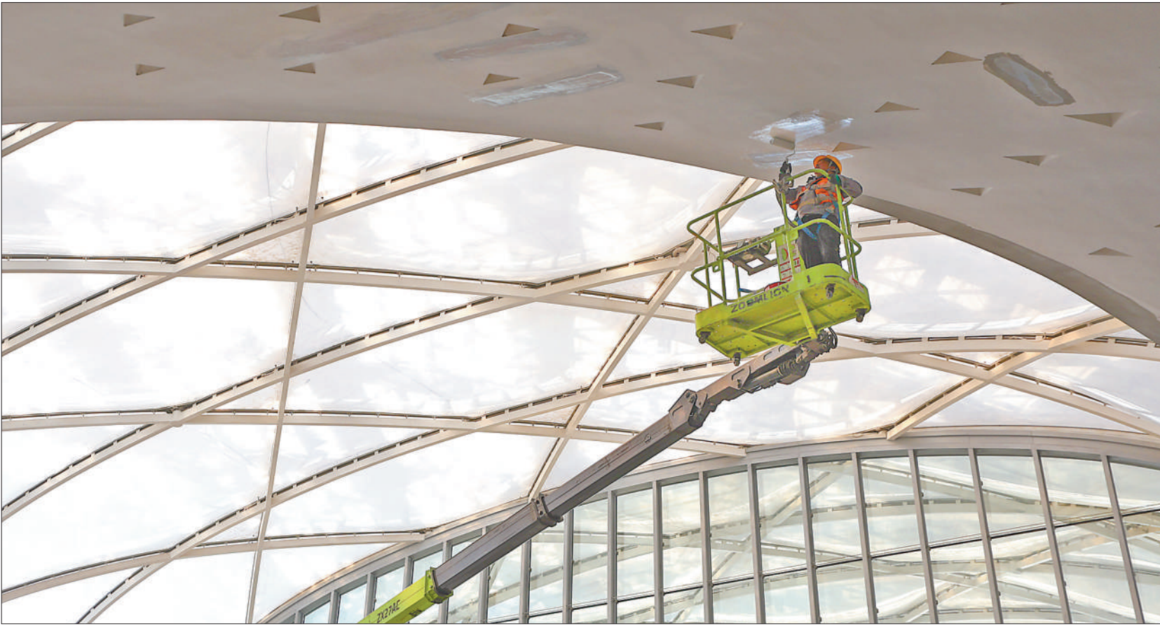
近日，北京城市副中心站综合交通枢纽施工加紧进行。据了解，北京城市副中心站综合交通枢纽施工02标段已完成地基与基础、主体结构（已验收）施工，正在进行装饰装修施工。图为工人在施工现场粉刷枢纽主体结构屋顶。 本报记者 张武军摄
