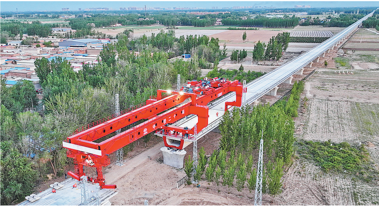
四月二十七日,雄安新区(商)高铁东清特大桥完成箱梁架设,最后一孔箱梁架设作业现场。图为当日,雄安新区高铁河北段
