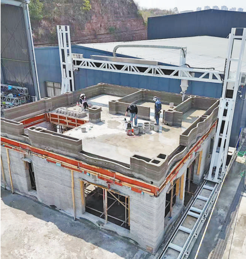
正在进行3D打印的双层楼房。
