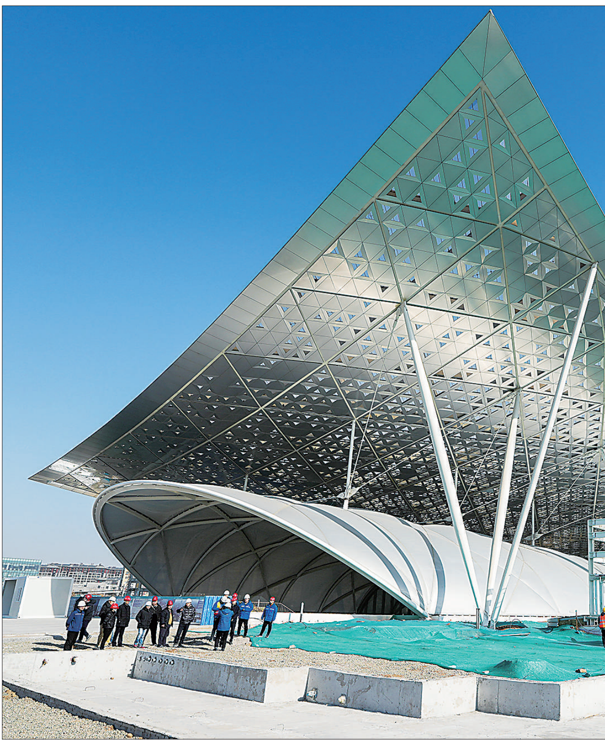
北京城市副中心站综合交通枢纽工程是“轨道上的京津冀”的重要节点，目前工程主体基本完工，正在进行设备安装、装饰装修和运营筹备等工作。图为这一枢纽工程的标志性建筑“京帆”。
