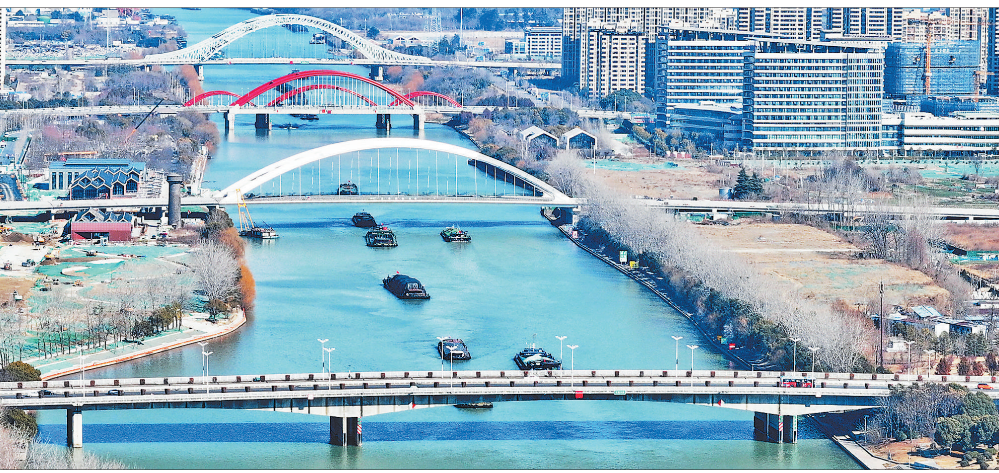
2月9日,京杭大运河江苏扬州段,货船在航道上有序航行,水运呈现一派繁忙景象。
