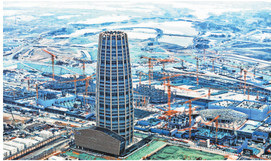
2月1日,河北雄安新区国贸中心建设工地一派繁忙景象。孙立君摄(影像中国)
