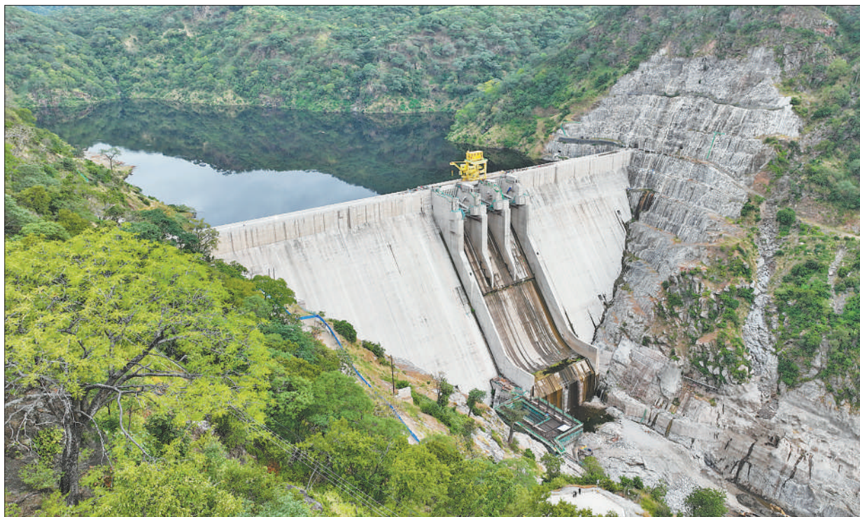
下凯富峡水电站大坝。
