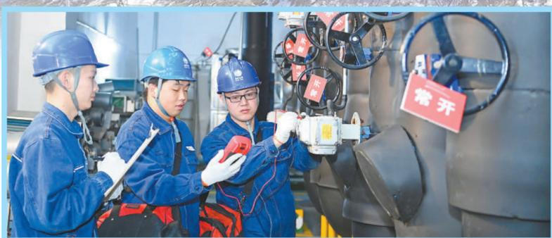
►近年来，安徽省滁州市逐步拆除老旧小区原有的燃煤锅炉供暖，改为地热、燃气等多种清洁能源供暖，惠及数十万户居民。图为国网滁州供电公司工作人员对居民小区地源热泵装置集中采暖系统的电气设备运行状态进行检查。
