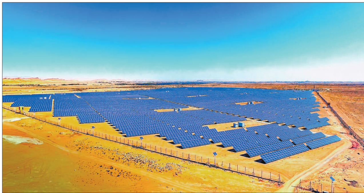
中国电建在阿尔及利亚南部承建的光伏电站项目，总装机容量233兆瓦，年发电量可满足约20万户家庭的用电需求。图为项目一景。 中国电建供图
