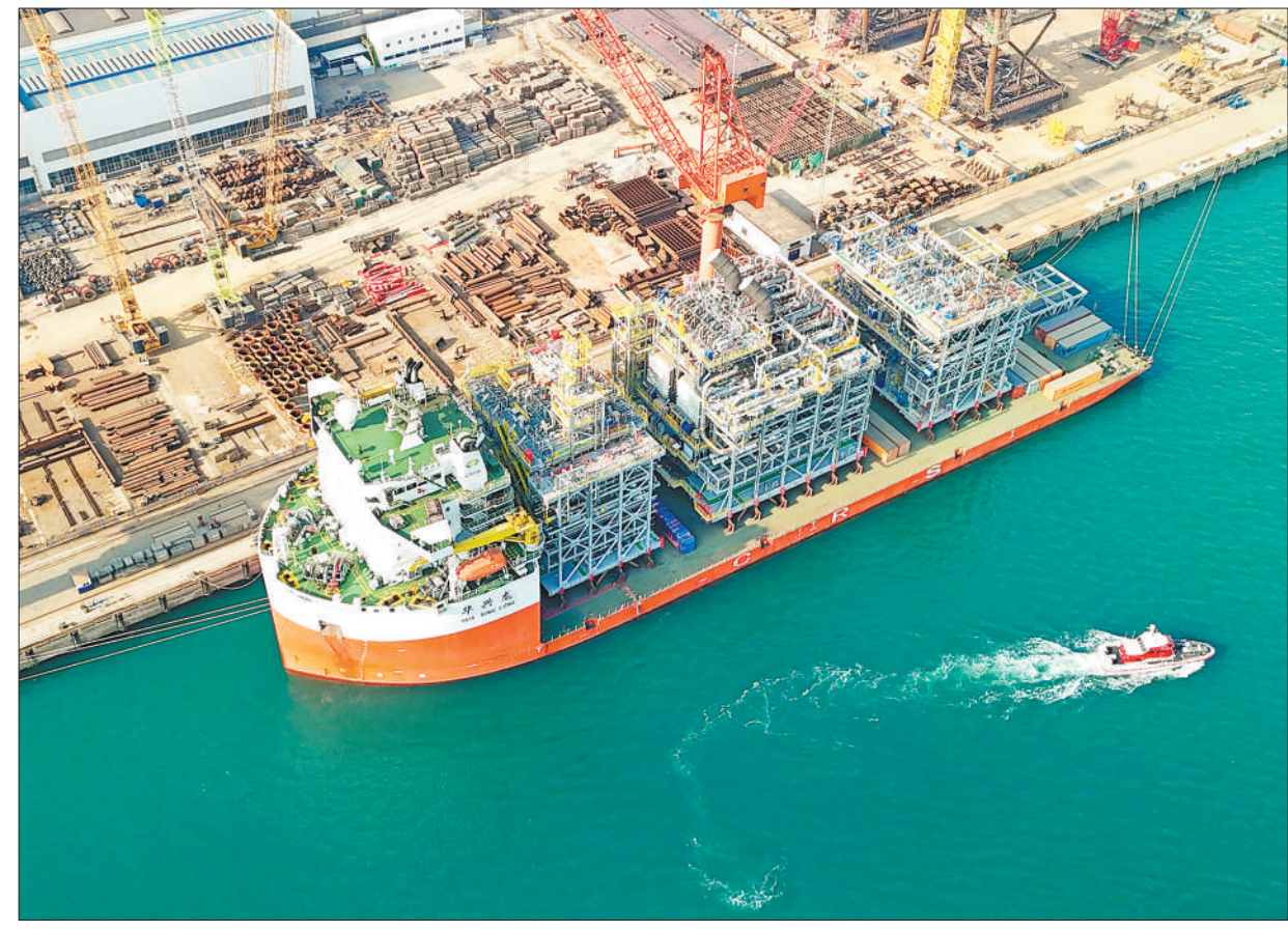
由海洋石油工程股份有限公司承建的巴西国家石油公司40万吨级P79 FPSO（浮式生产储卸油装置）项目上部模块，从青岛装船启运，至此，该项目13个上部模块全部完工交付，标志着我国高端海洋能源装备制造能力再获新突破。据了解，P79 FPSO船体总长345.3米，型宽60米，最大排水量达40万吨，建成后将服役于巨型深水油田巴西桑托斯盆地布济乌斯油田，作业水深超过2000米。
